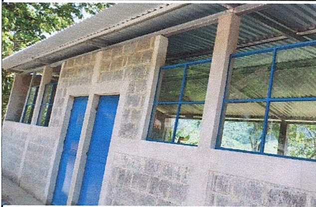
Foto 3: MEJORAMIENTO DE PUERTAS Y VENTANAS
