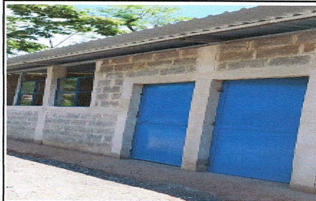
Foto 4: MEJORAMIENTO DE PUERTAS Y VENTANAS
