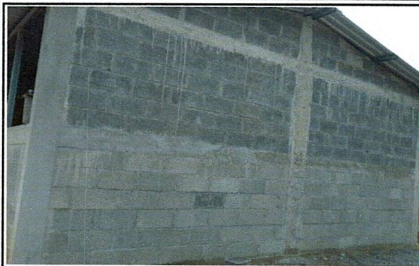
Foto 2: MEJORAMIENTO DE PAREDES
