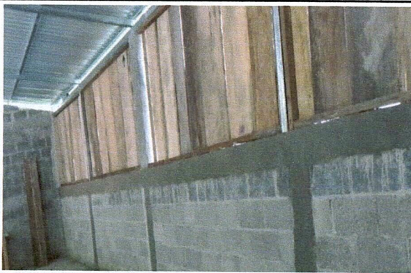
Foto 3: MEJORAMIENTO DE PAREDES
