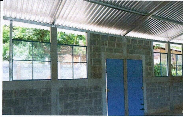
Foto 1: MEJORAMIENTO DE PAREDES
